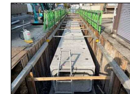
【函渠の布設状況】
