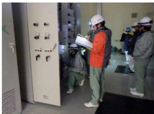
【電気設備年次点検の様子】
