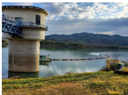
【浚渫作業をしている様子】
