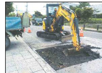
【舗装補修状況】
