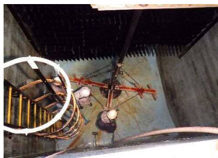
【沈殿池内清掃の様子】
