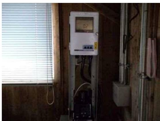
図. 原水濁度計
