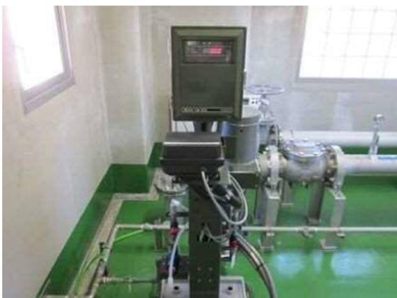
図. 原水濁度計
