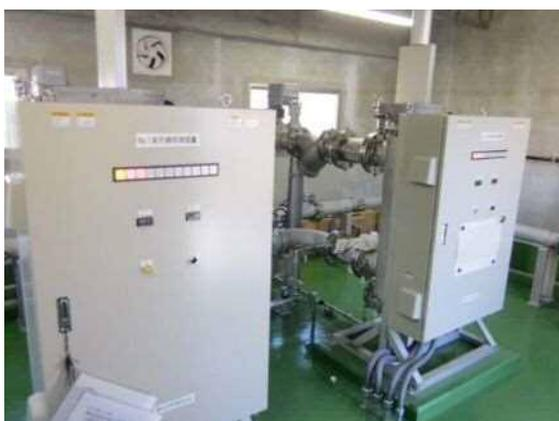
図. 紫外線処理設備
