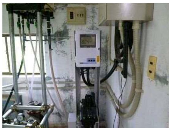
図. 浄水濁度計
