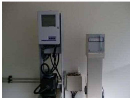
図. 浄水濁度計
