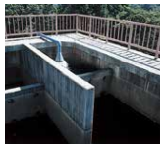
3 着水井(ちやくすいせい) 浄水場に到着した水は、最初にこの池に入ります。ここでは水の濁り具合など、水質の状況を確認し、次の混和地での薬品注入量などを決めます。
