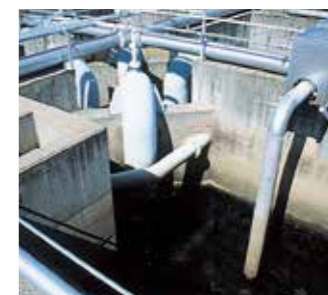
7 急速ろ過池(きゅうそくろかち) この池では、ろ過材(砂利・砂)を通してろ過し沈殿しきれなかったゴミを全て取り除きます。そして消毒薬(次亜塩素酸ナトリウム)を入れます。これで飲める水「浄水」の完成です。
