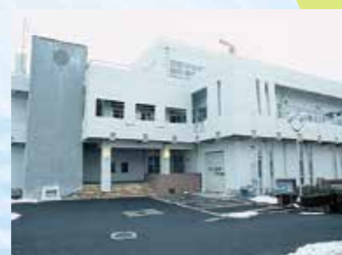
11 管理本館 保呂羽浄水場の管理を行っているところです。
