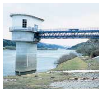
1 下り松取水塔 北上川の水をポンプで汲み上げます。塔内には、1台あたり1日10,426m 3 の汲み上げ能力を持ったポンプ4台(1台は予備)が設置されています。
