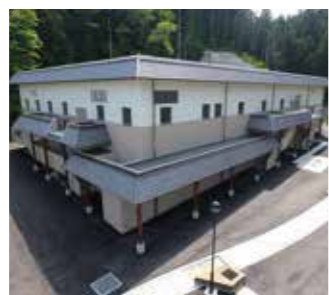
2 下り松ポンプ場 取水塔で汲み上げられた水に含まれる砂や土などを沈殿させて取り除いた後、浄水場へ送ります。カビ臭など水質の変動に対応して活性炭を注入することができます。
