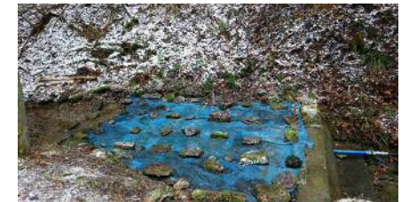
清掃後の状況
