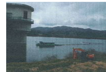
浚渫作業状況
