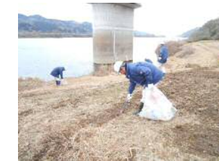
清掃作業状況
