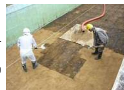
ろ過砂の表面を掻き取り清掃している様子
