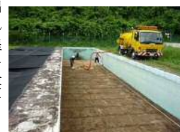
ろ過砂をバキューム車で搬出している様子
