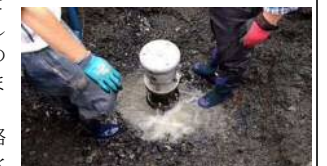
空気弁接合部からの漏水状況
