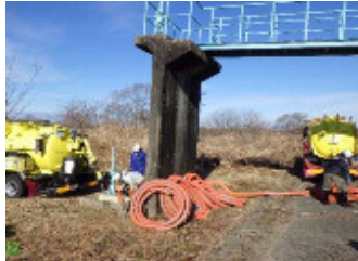
【樋管清掃の準備をしている様子】
