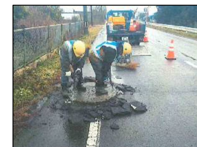
【高さ調査作業の状況】
