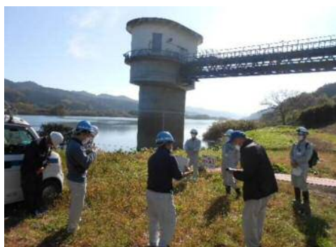
【下り松取水塔付近を点検している様子】
