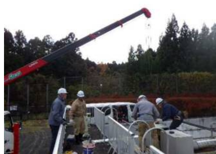
【ろ過池表洗弁漏水修理の様子】
