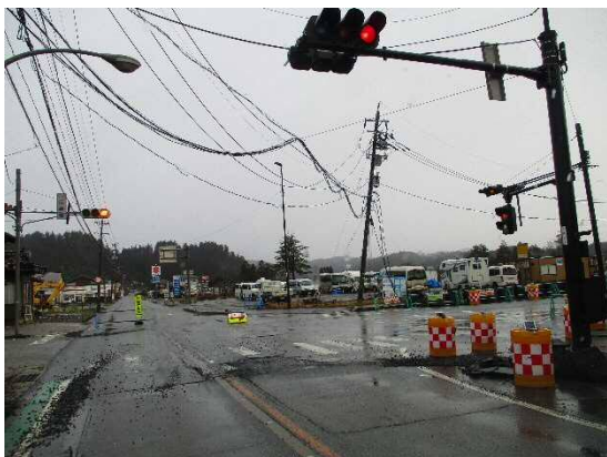
道路の陥没や垂れ下がった電線による迂回など、交通状況は非常に悪いものでした
