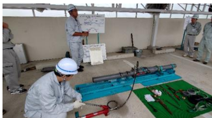
【配管の接合の説明を受けている様子】
