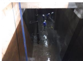
【下り松ポンプ場沈砂池清掃作業の状況】
