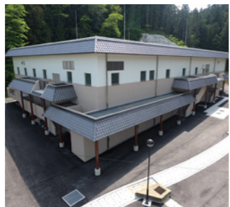
2 下り松ポンプ場 取水塔で汲み上げられた水に含まれる砂や土などを沈殿させて取り除いた後、浄水場へ送ります。カビ臭など水質の変動に対応して活性炭を注入することができます。
