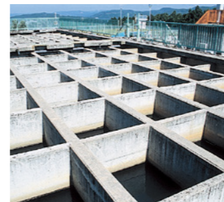
5 フロック形成池 水の中の汚れの粒子は、この池をゆっくりと流れながら、しだいに大きなフロックとなります。 ※フロックとは凝集剤などを添加したことにより生じる汚れのかたまりです。
