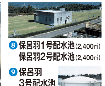
8 保呂羽1号配水池(2,400m 3 ) 保呂羽2号配水池(2,400m 3 ) 9 保呂羽3号配水池(3,800m 3 ) 10 保呂羽4号配水池(6,100m 3 ) 浄水は一旦これらの配水池へ溜められ、配水管を通して、皆さんのもとへ送られます。
