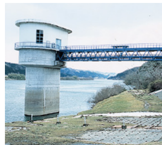
1 下り松取水塔 北上川の水をポンプで汲み上げます。塔内には、1台あたり1日10.426m 3 の汲み上げ能力を持ったポンプ4台(1台は予備)が設置されています。
