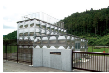
米川増圧ポンプ場
