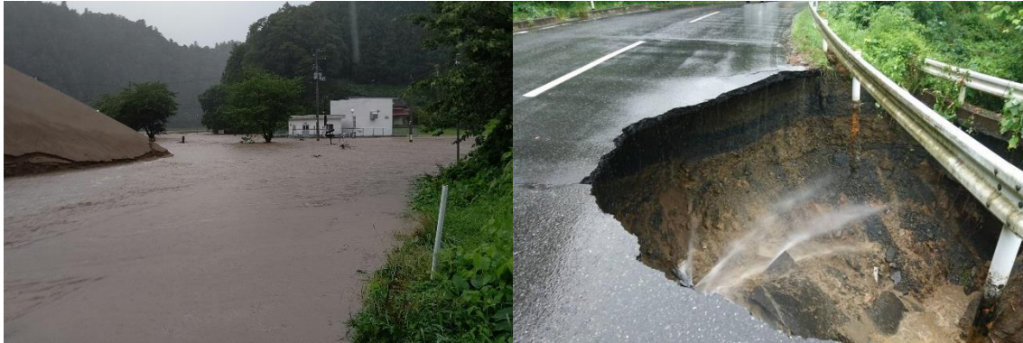
図 5-6 浸水する米谷浄水場と道路陥没による漏水
