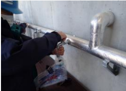
【給水袋への補水訓練の様子】
