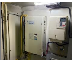
【修繕後の状況】
