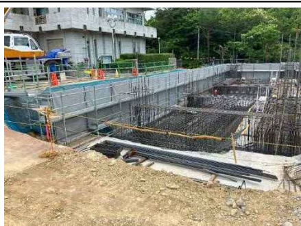
②管理・膜ろ過棟底板鉄筋組立の写真
