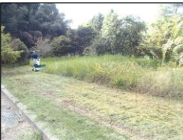
【除草作業の状況】
