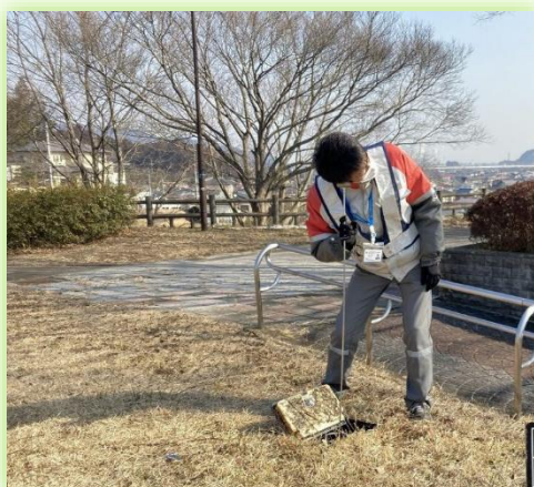
音聴棒で行う漏水有無の調査
