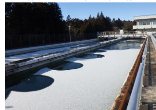
【散水ポンプ稼働状況】
