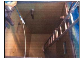
【曝気沈砂槽防食作業の状況】
