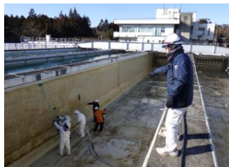
【清掃作業の様子】
