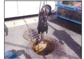
【ポンプ修繕の状況】
