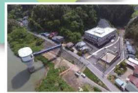
下り松ポンプ場
