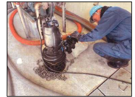
【流調攪拌装置交換の状況】
