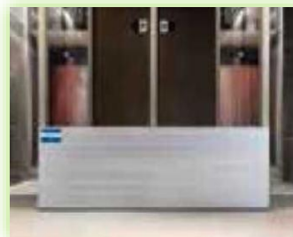
止水版の設置
