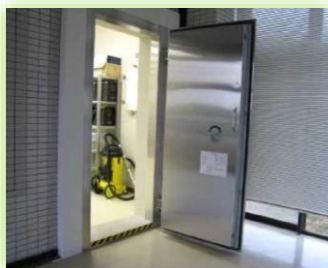
耐水扉の設置
