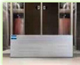
止水版の設置
