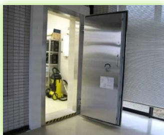
耐水扉の設置
