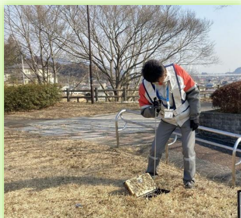
音聴棒で行う漏水有無の調査
