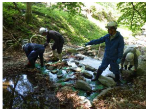
【取水口清掃の様子】
