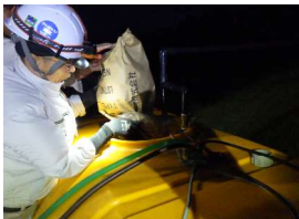
【仮設注入設備設置の様子②】
