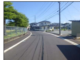
【舗装復旧後の状況】
