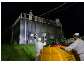
【仮設注入設備設置の様子①】
