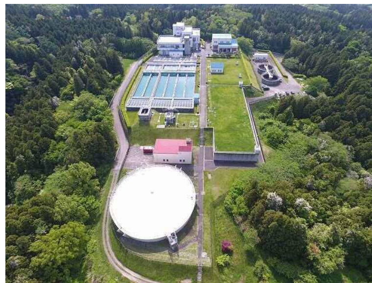
保呂羽浄水場全景写真
