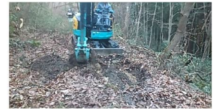
漏水箇所を掘削している様子
