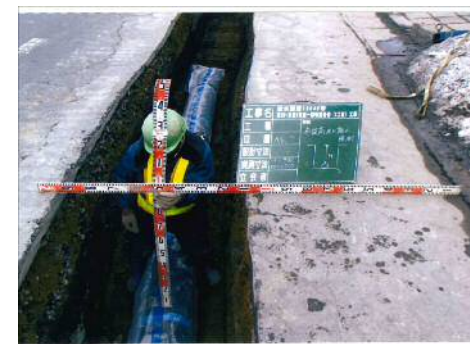
水道管布設完了状況
