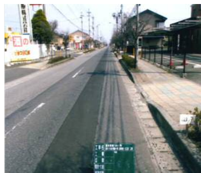
加賀野地内完了状況
