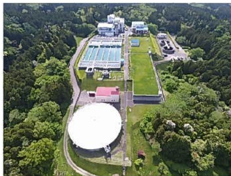
保呂羽浄水場全景写真
