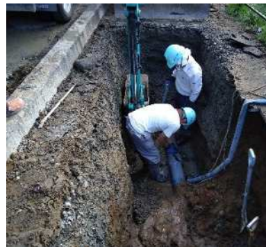
【復旧工事の様子】
