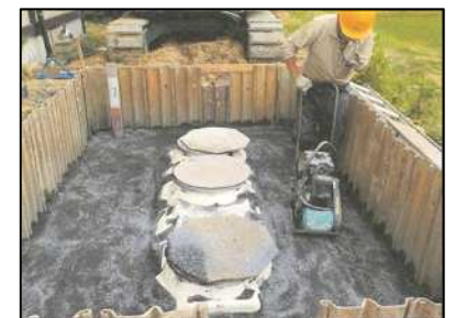
【浄化槽設置工事状況】
