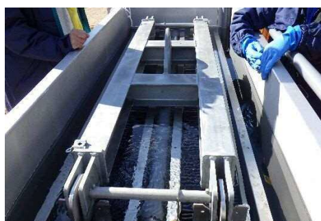
【膜ろ過ユニット薬品洗浄の様子】
