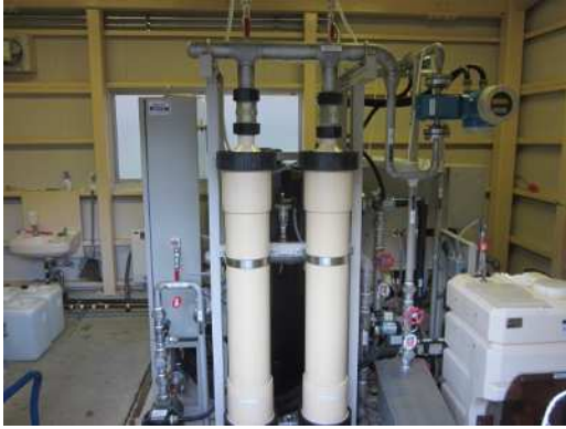
膜ろ過装置全景 (合ノ木・大綱木浄水場)
