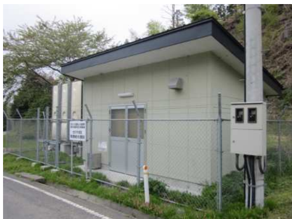
合ノ木浄水場全景
