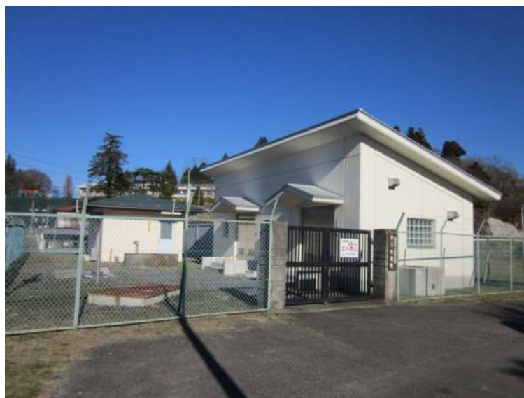
米川浄水場全景
