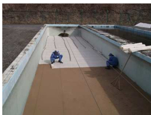
目詰まり防止シート敷設状況
