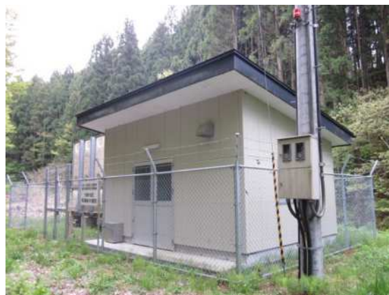
大綱木浄水場全景
