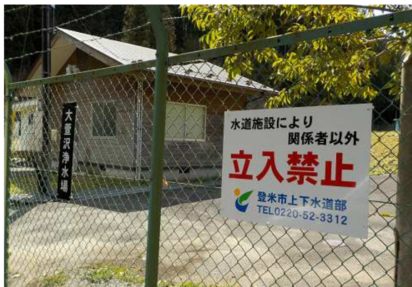
大萱沢浄水場全景
