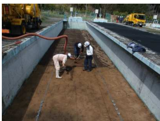
砂の掻き取り作業状況
