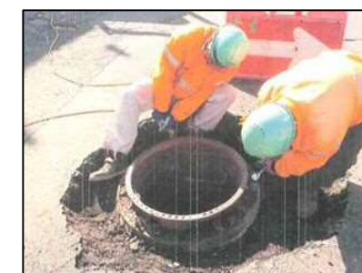
【マンホールの高さ調整の状況】
