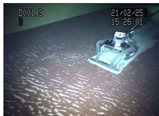
【水中ロボット清掃作業（イメージ）】
