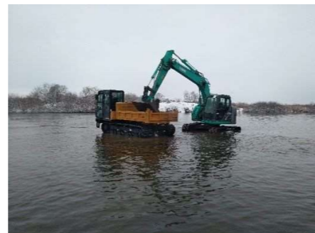
【浚渫作業状況】
