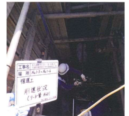
【汚水管渠築造工事状況】
