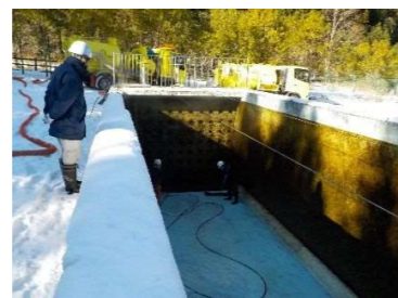
【沈殿池清掃状況】
