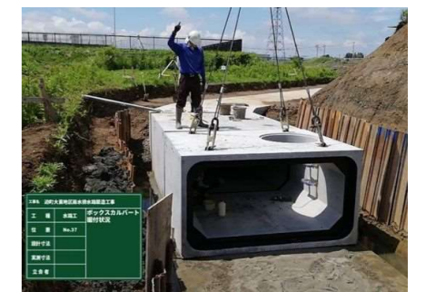
【令和元年度工事状況】
