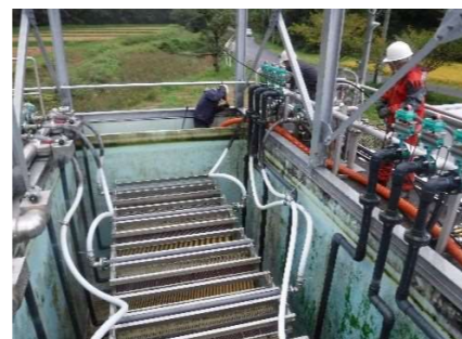
【膜ろ過設備浸漬槽清掃状況】
