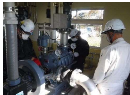
【グランドパッキン交換状況】
