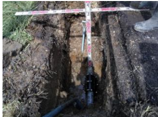
【復旧工事の状況】
