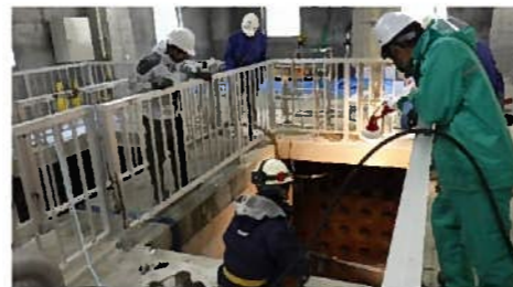
【沈砂池清掃状況】
