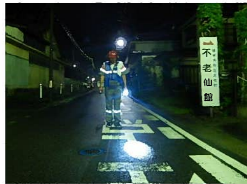
【路面音調調査状況】
