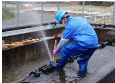
【木栓による仮止水をしている様子】
