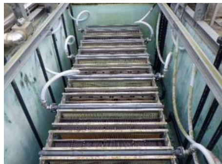
【浸漬槽清掃作業後の様子】
