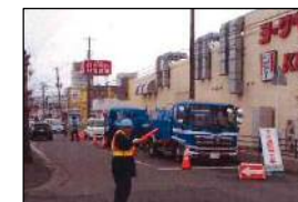
【下水管渠の閉塞対応の状況】
