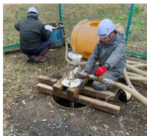
【取水井清掃後の揚水試験の様子】
