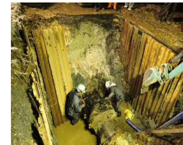
1号線漏水修理工事
