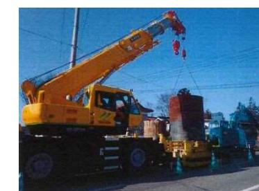
【仮設ケージ 建込状況】
