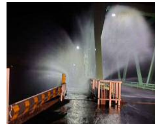
○地震による施設の被災状況
