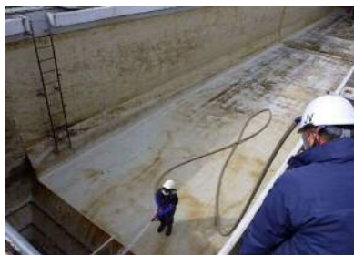
【1号沈殿池清掃作業状況】
