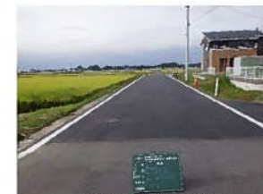
【舗装本復旧の完了】
