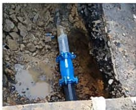
【漏水箇所修理状況】
