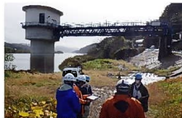
【下り松取水塔付近点検状況】
