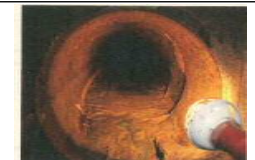
導水管 800mm土砂堆積状況
