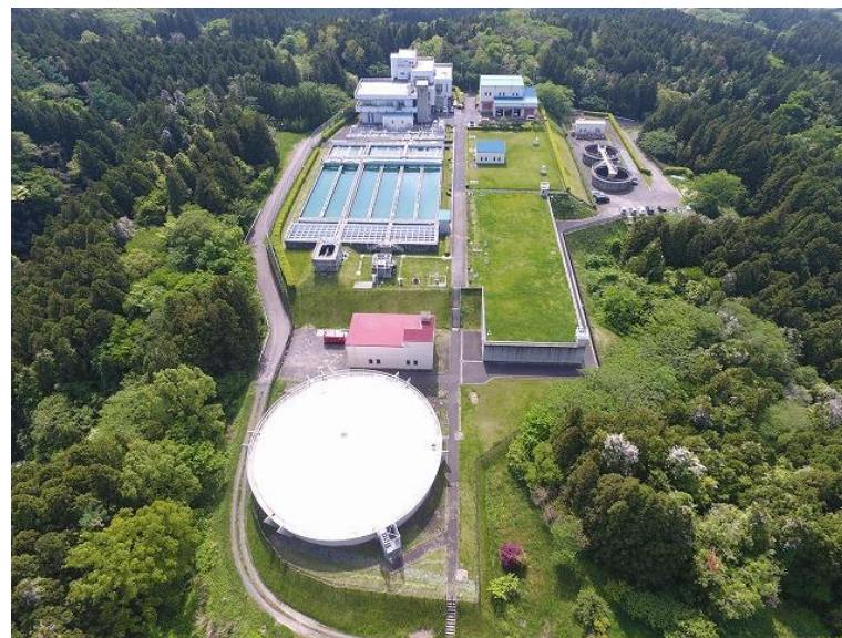
保呂羽浄水場全景写真
