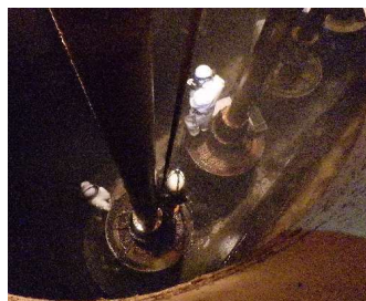
【取水ポンプ清掃作業の状況】
