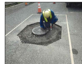
【作業状況写真】
