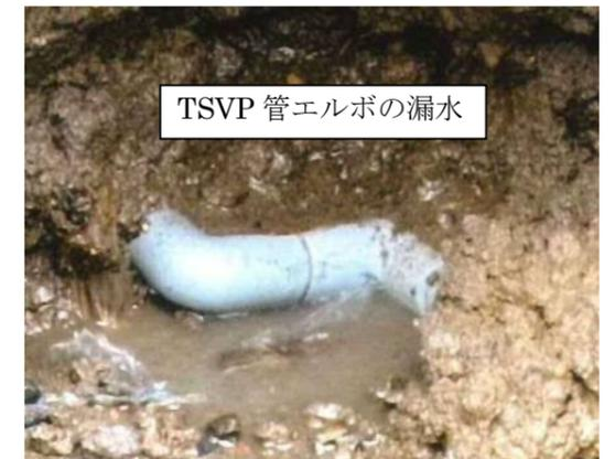
\*TSVP管とは、水道用塩化ビニール管でソケット接合する管種です。
