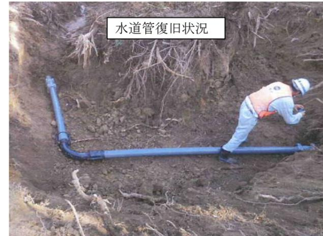
20日午前10時20分頃、東和町米谷字福平地内の三陸道建設現場で、VP100mmの水道管破損事故が発生しました。この事故により平倉配水池の水位が急激に下がり、本配水池が空になる危険状態が発生しました。一旦空になると充水までに数十時間を要し、断水時間が長くなることから、弁操作により緊急断水としました。
